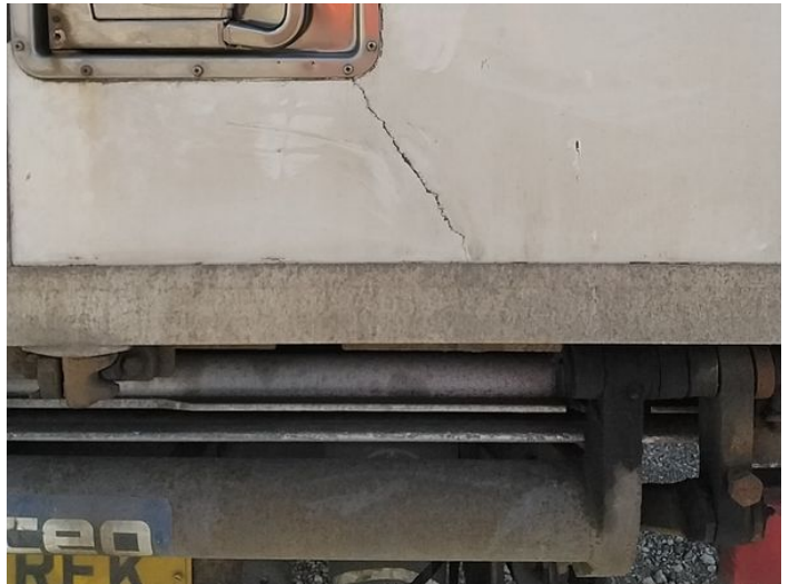
6: Door osr Cracked Replace
