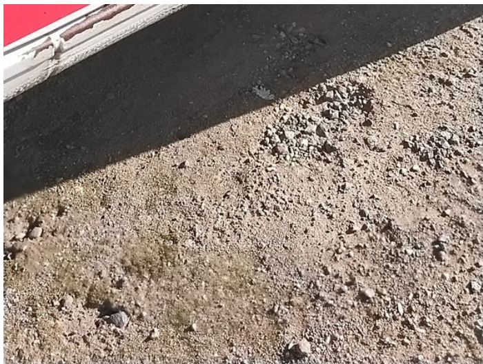
3: Sill os Chipped Edge Chip
